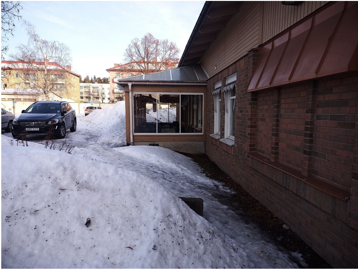
Figur 15: Gångtrafikanter mellan parkering och Tälle 24:14 hindras av betongsugga, utbyggnad och snömassor.
