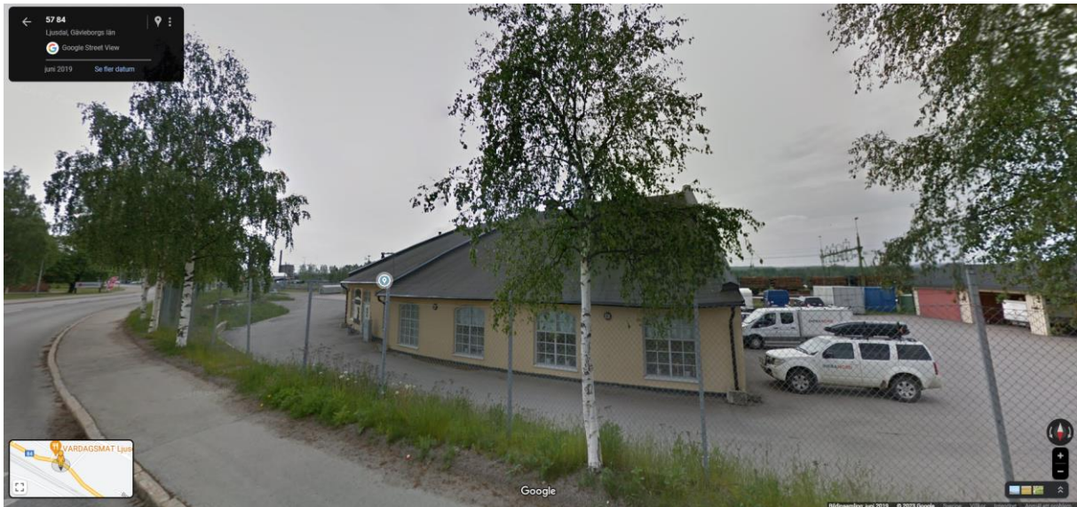
Figur 2. Lokstallsplats som kan fungera som ett skydd mot järnvägen. Planområdet till vänster utanför fotot (Google maps, 2019).
