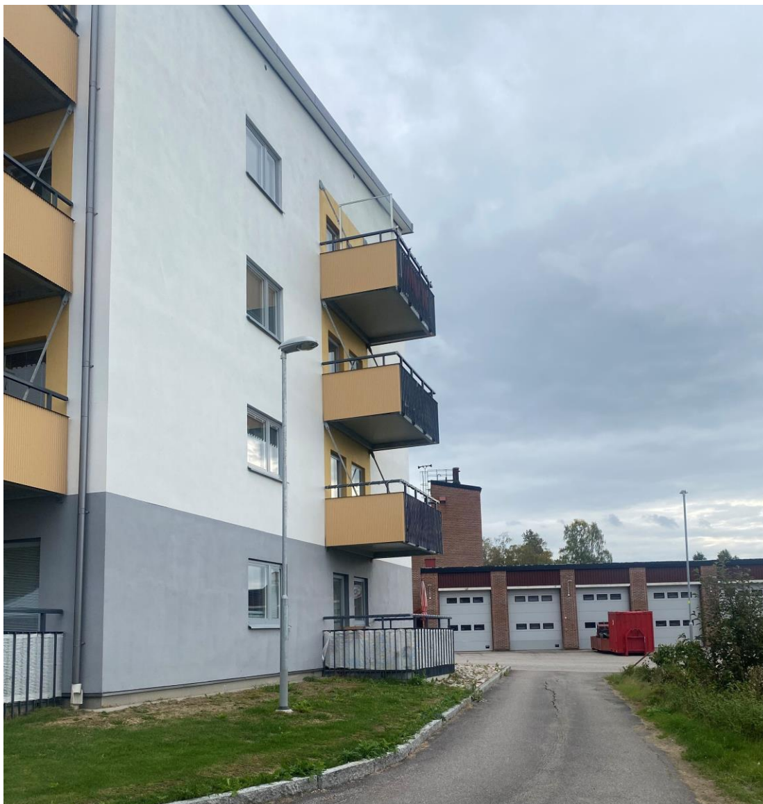
Figur 2: Ny byggnad norr om planområdet
